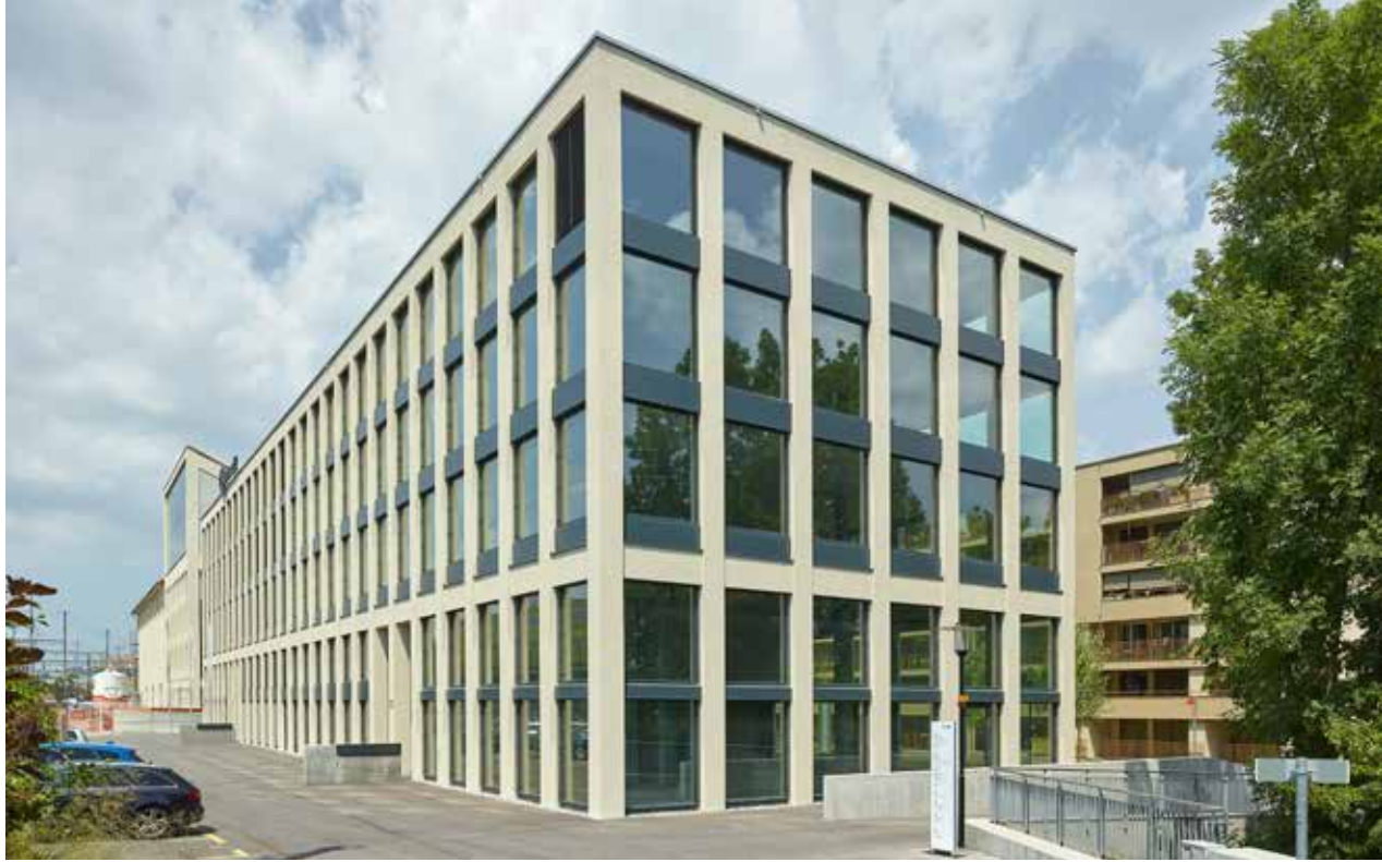
Die Büroflächen sind in erster Linie für Grossraum- und Clusterbüros vorgesehen.
